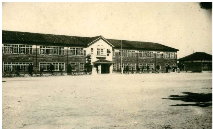
阿閑小学校木造2階建て校舎
